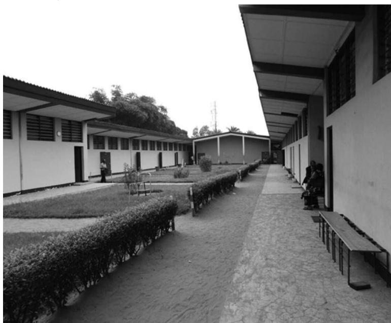
Vue des bâtiments du lycée Kingasani 2
