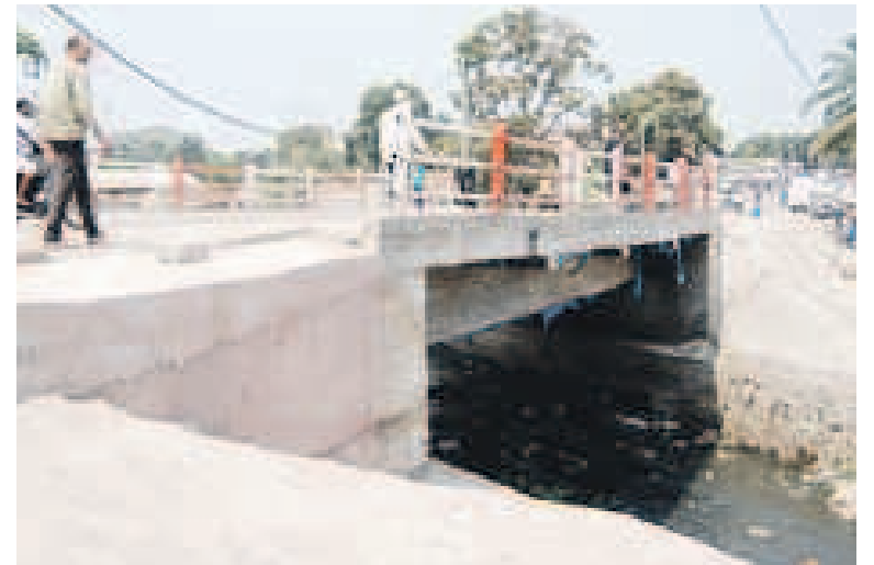
Une vue du pont Makelele dans la commune de Bandalungwa (photo John Bompengo)
