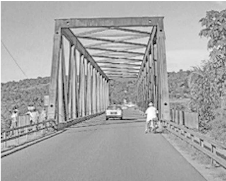
Le pont sur la rivière Lubilanji
