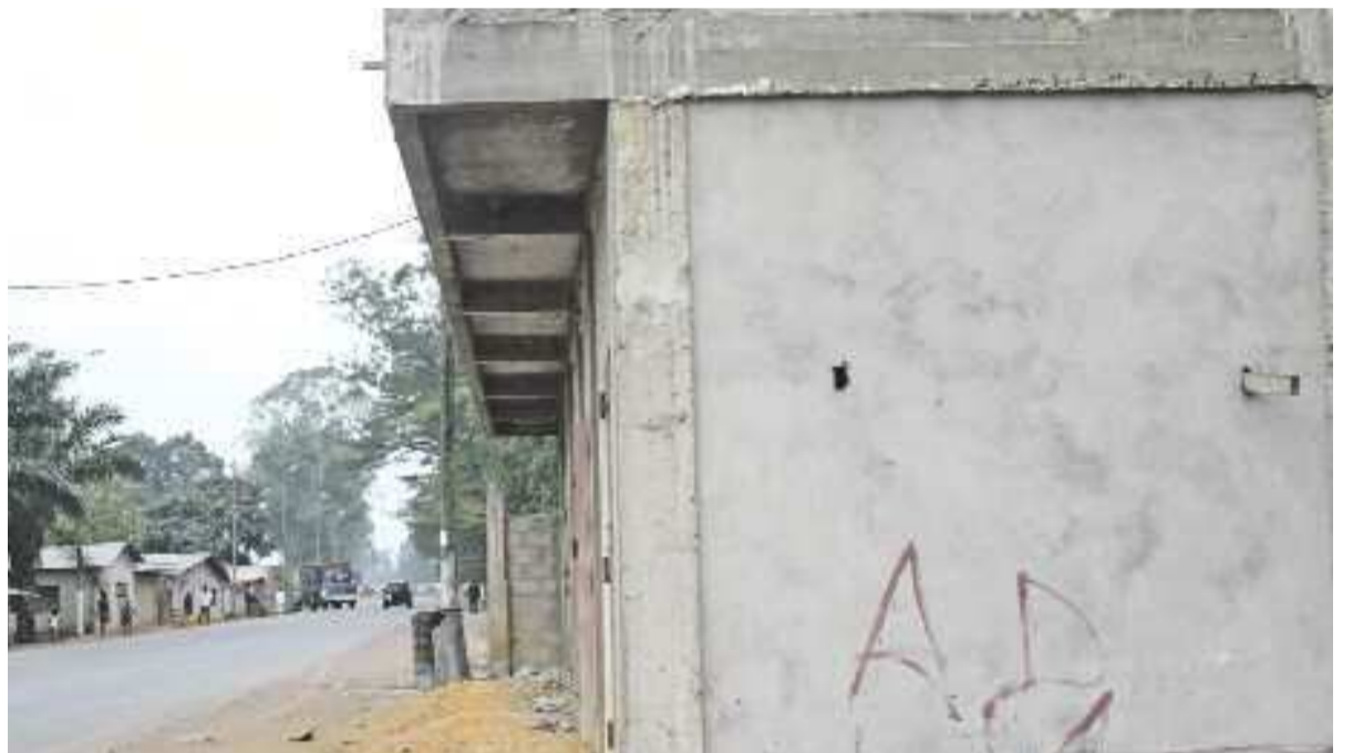
Un bâtiment ciblé par la démolition
