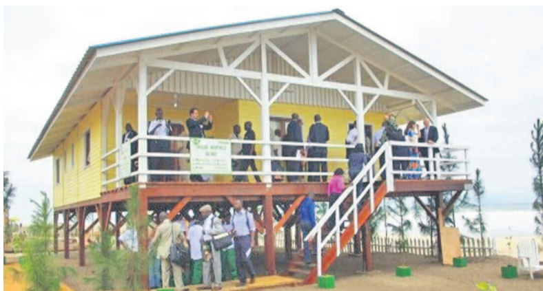
Une maison en bois exposée au racewood en 2011 (Crédit MEFD)
