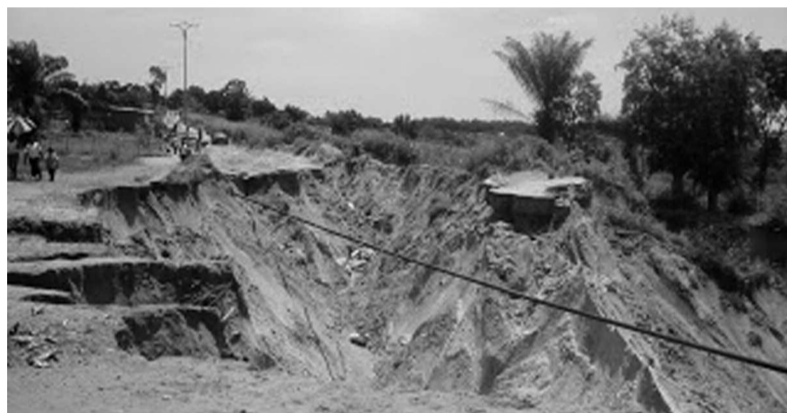
Une érosion qui peut être freinée par drainage et boisement ou planning d'arbres
