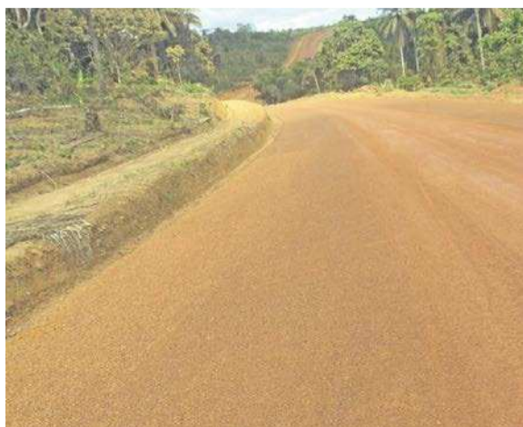
Vue d'une route latérite à l'entrée de Mossendjo
