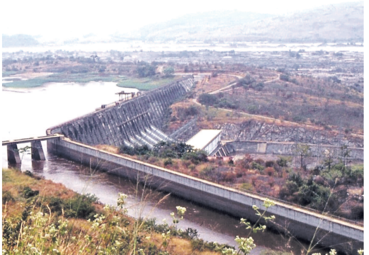
Le barrage hydroélectrique d'Inga
