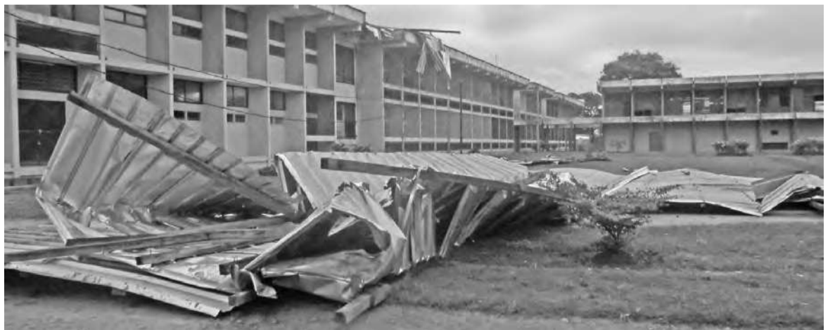
La toiture de l'ENS au sol
