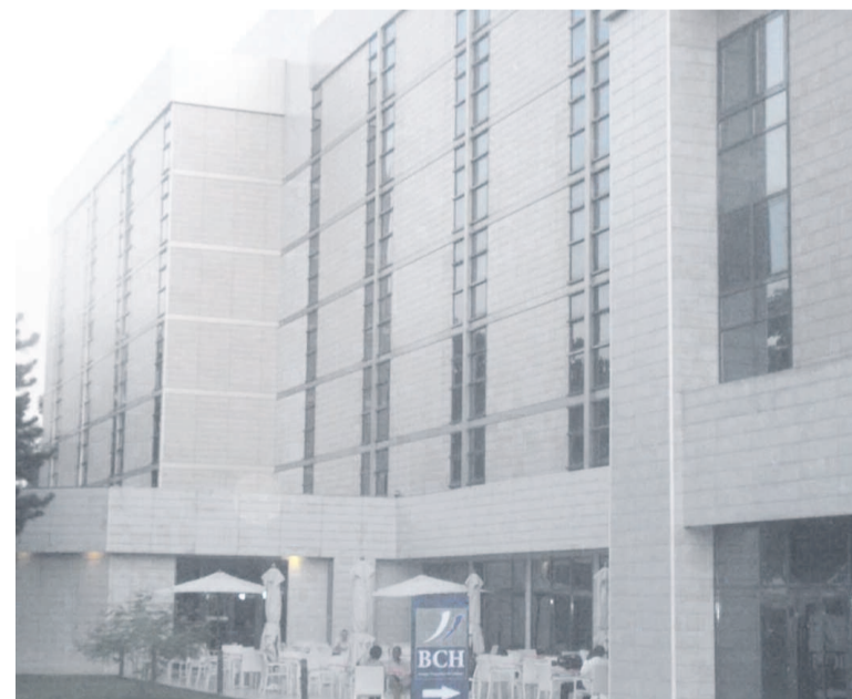
Une façade du Ledger Plaza Maya Maya
