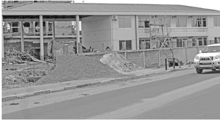
Bâtiment des sapeurs pompiers en construction au pont de la Tsiémé
