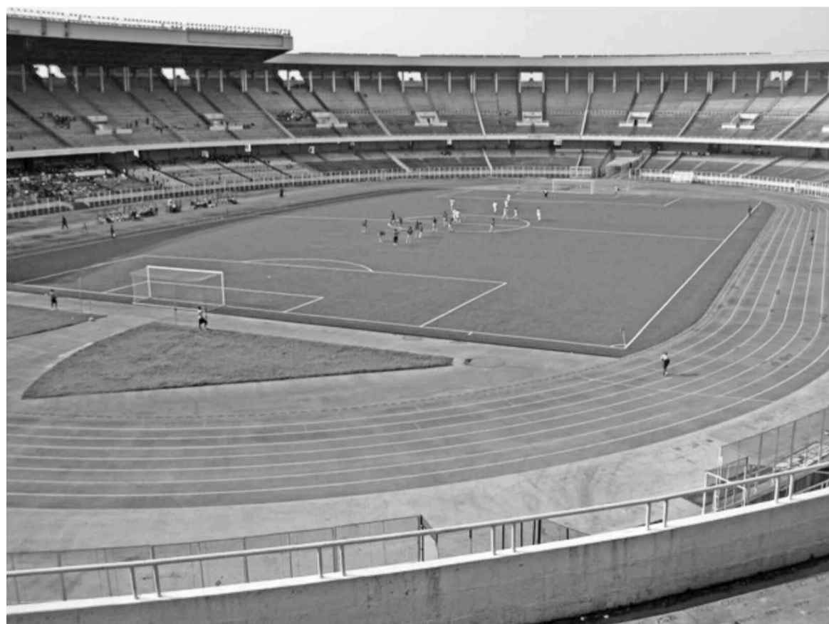
Le stade des Martyrs de Kinshasa sera fermé durant 13 mois pour des travaux de réhabilitation
