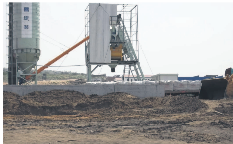
Un site en phase d'aménagement
