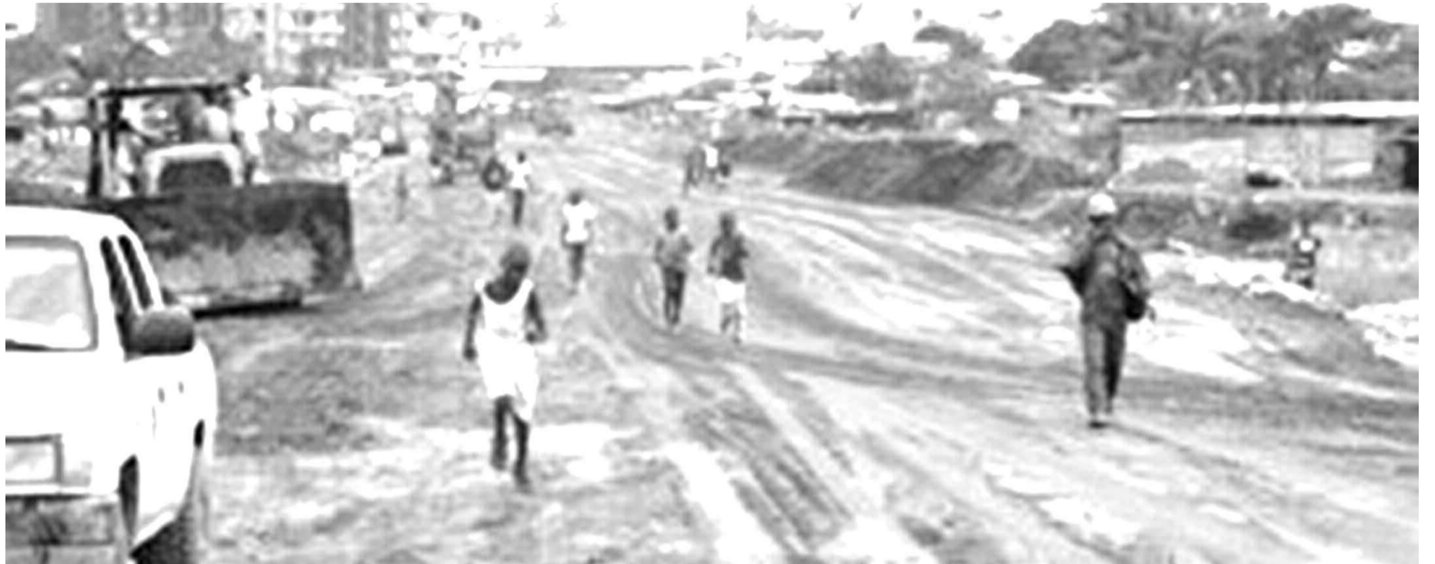
La route de la CNSS est en travaux crédit photo "Ad"
