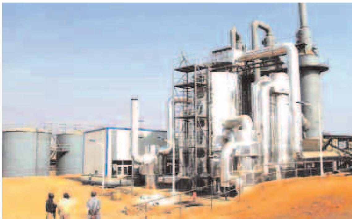
Une vue partielle des installations de la Gecamines
