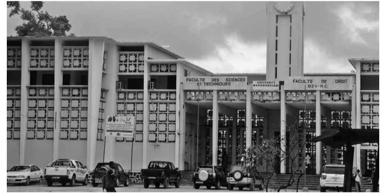
La façade principale
