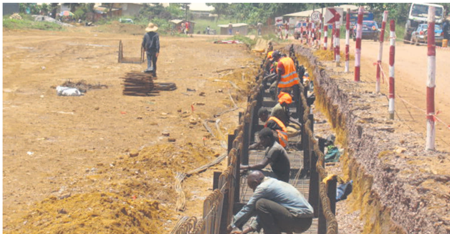
Les ouvriers à pied d'oeuvre sur le futur boulevard de Sibiti
