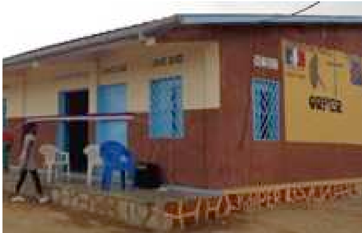
Le bâtiment abritant le dortoir ayant une capacité de cent lits
