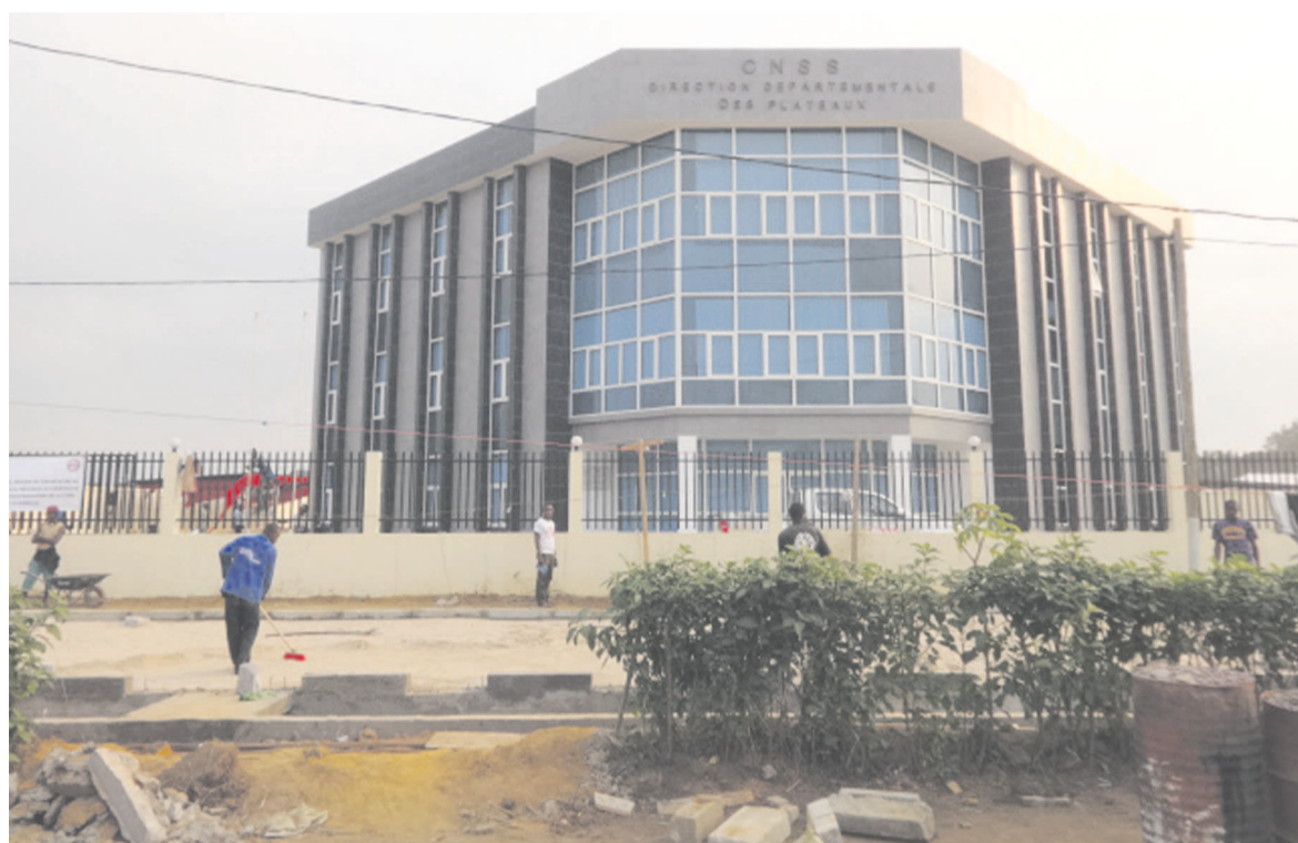
Le siège de la CNSS à Djambala
