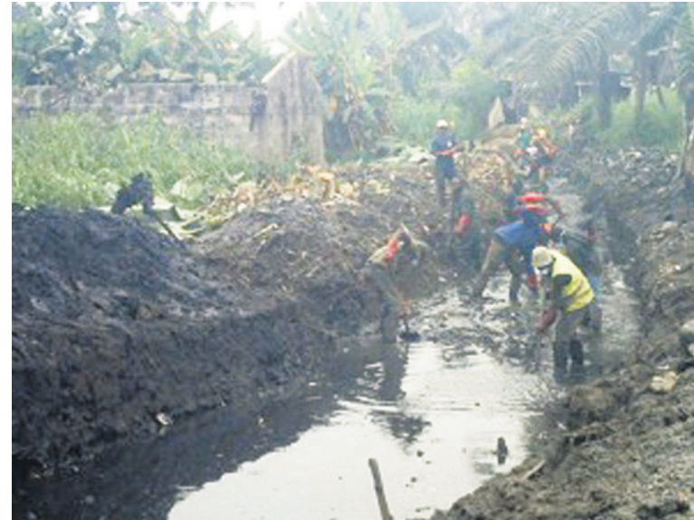
Les tâcherons entrain de faucarder un cours d'eau Crédit photo:Adiac»
