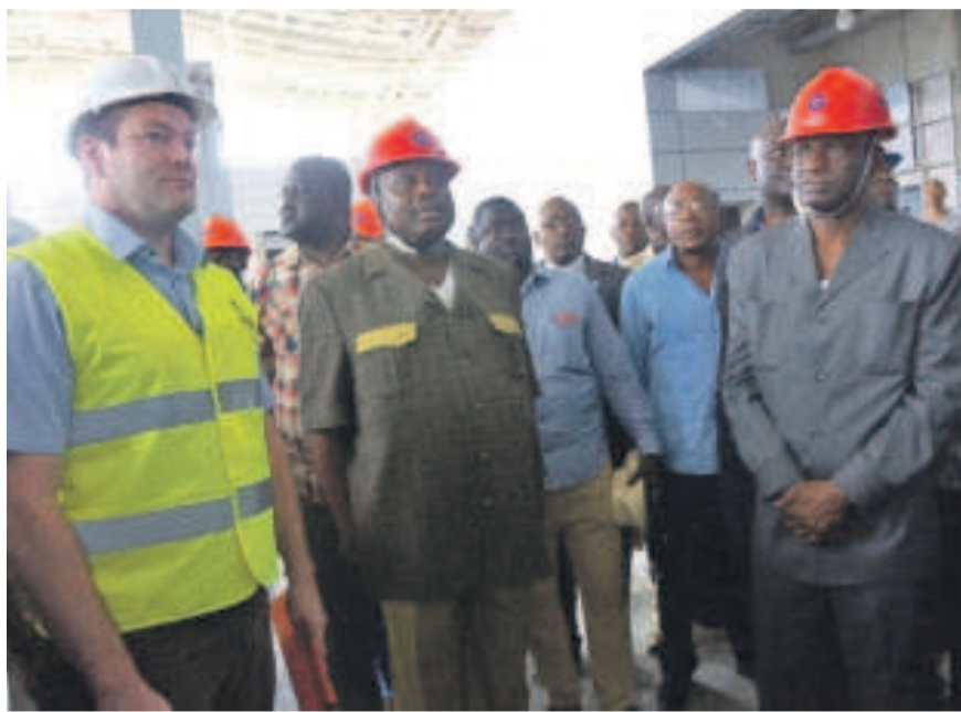
Le ministre et sa suite visitant les travaux du nouveau siège de l'aéroport de Pointe-Noire
