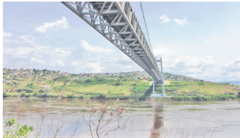
Les constructions anarchiques en-dessous du pont maréchal
