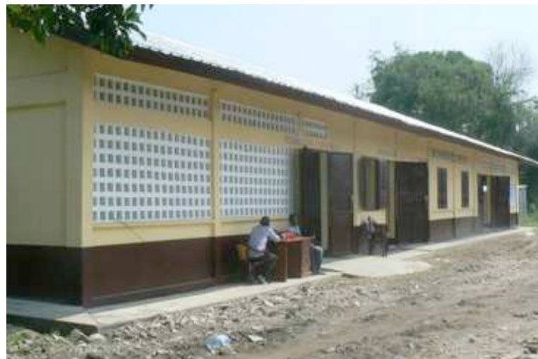
Le nouveau bâtiment
