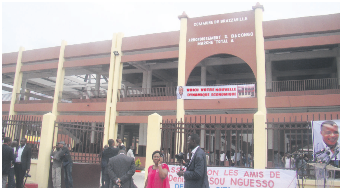
La façade principale
