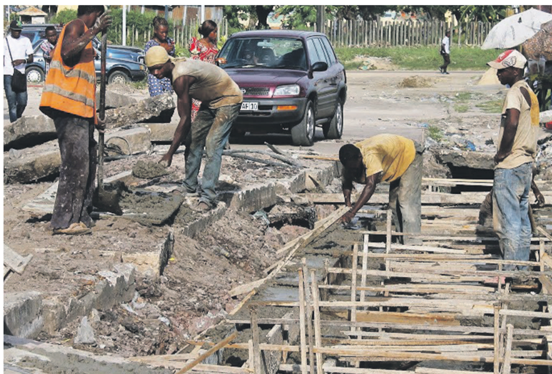
Travaux de réhabilitation des caniveaux aux abords du stade Tata-Raphaël
