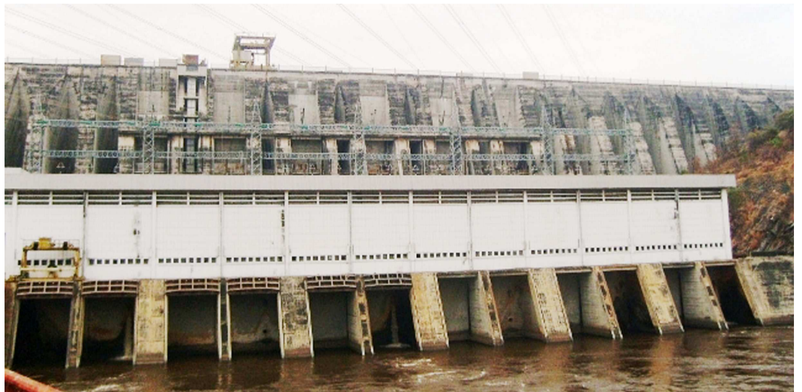
La centrale hydro-électrique d'Inga
