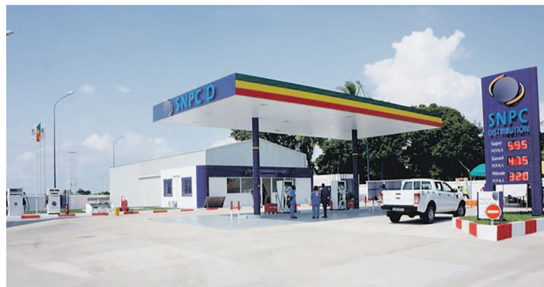
La nouvelle station de la SNPC D à Tchiamba Nzassi
