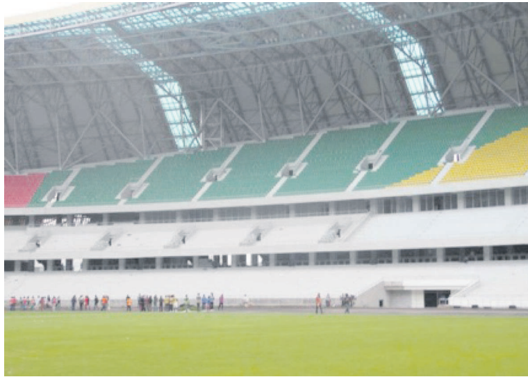
Une vue partielle du stade olympique de Kintélé (photo adiac)
