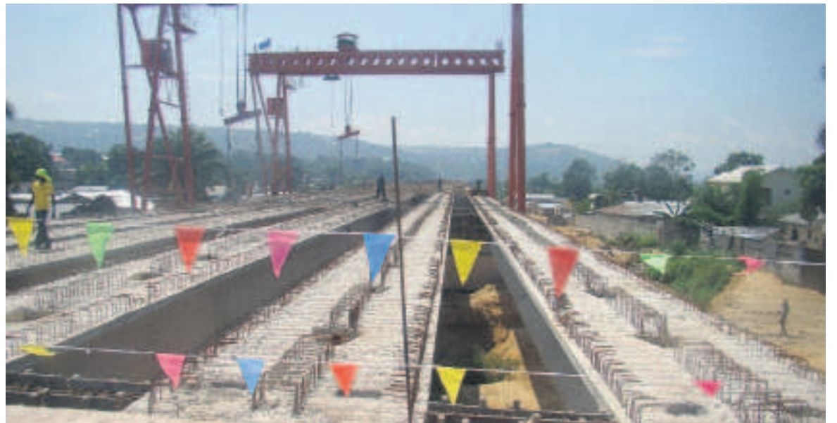
Le viaduc en construction
