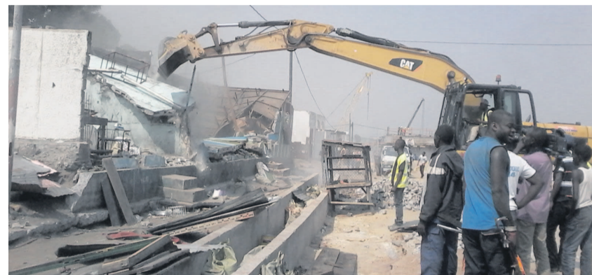
Un engin en pleine démolition des habitations dans la zone expropriée à Talangai
