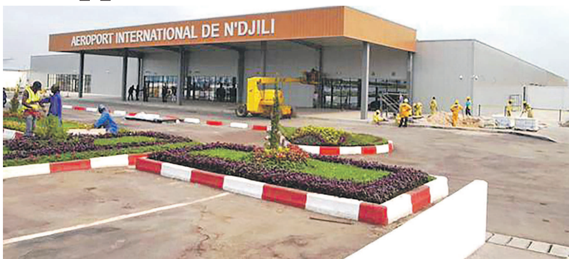
L'aérogare modulaire de l'Aéroport international de N'djili.
