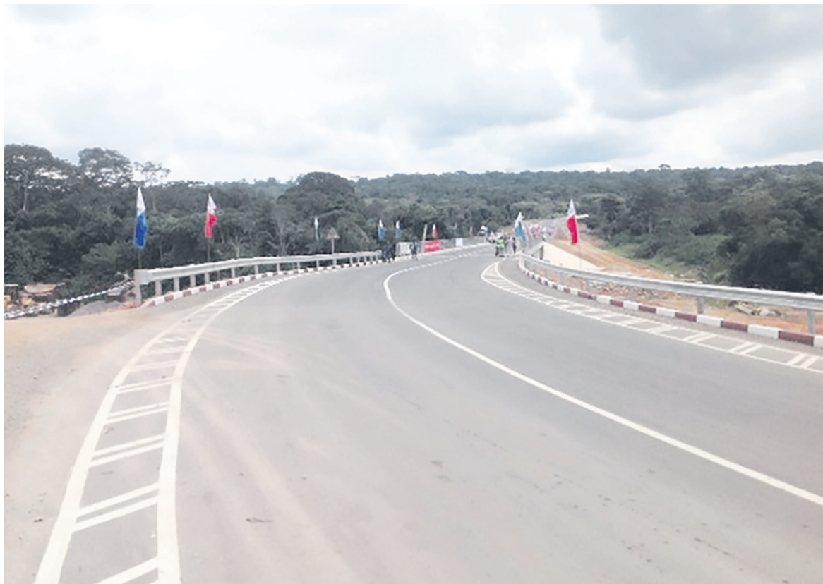
Une vue de la route entre Ouesso et Mambili @adiac
