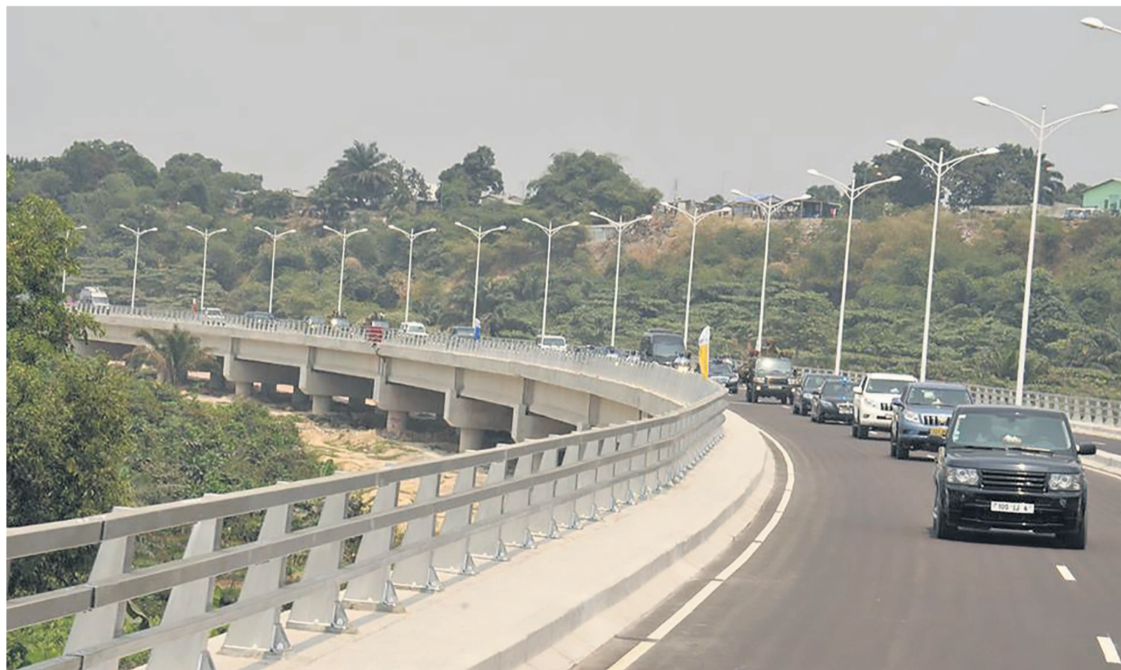
La longueur totale de cette infrastructure routière est de 6,865 km
