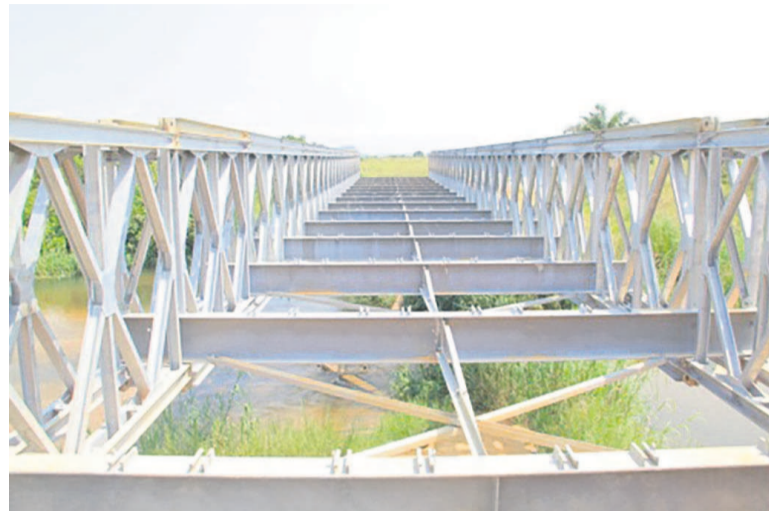
La construction des ouvrages de franchissement parmi les actions phares en 2016/ crédit photo Adiac.
