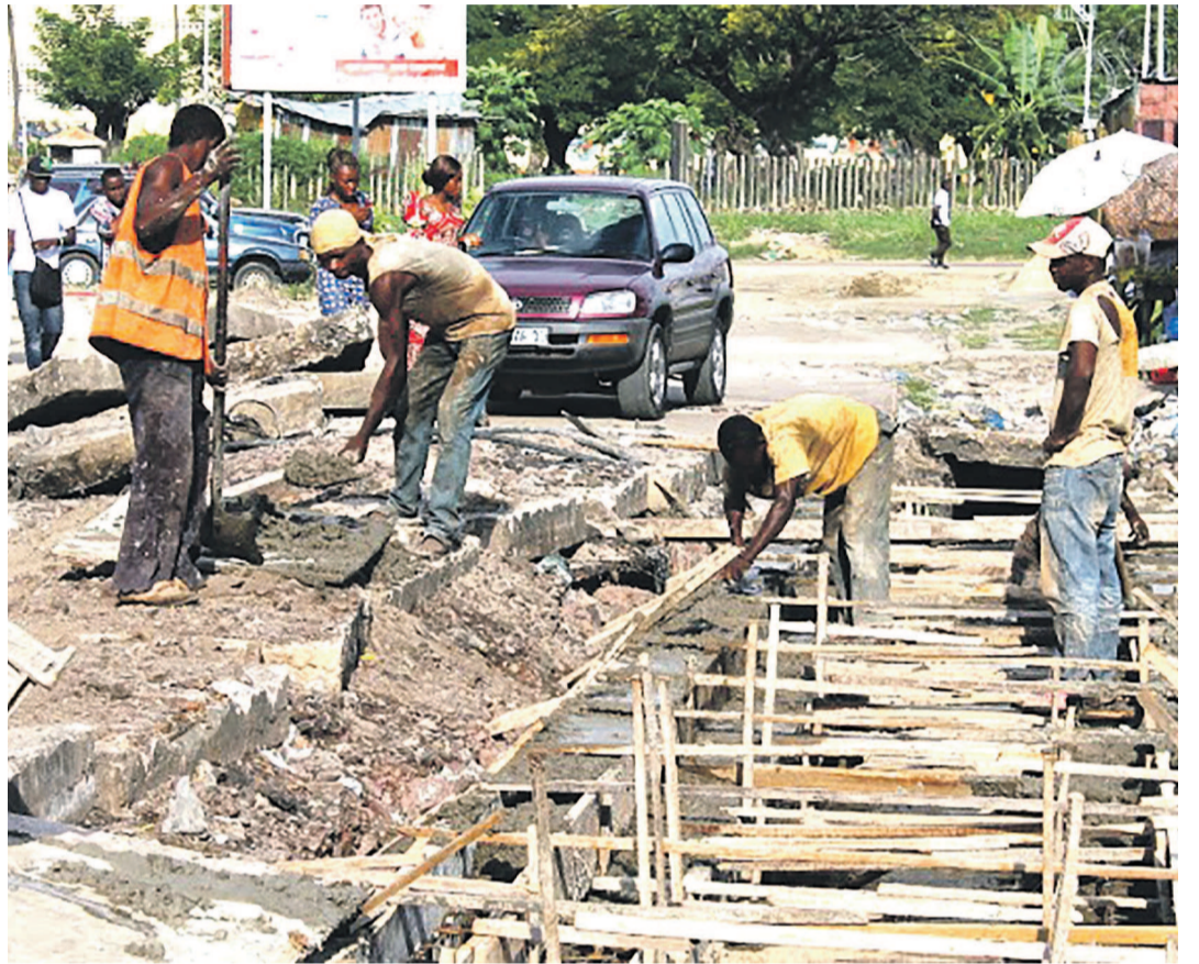
Travaux de réhabilitation d'une route à Kinshasa
