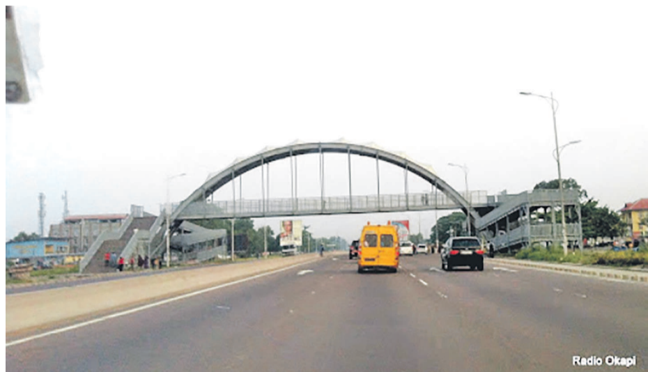
Une passerelle sur le boulevard Lumumba réhabilitée
