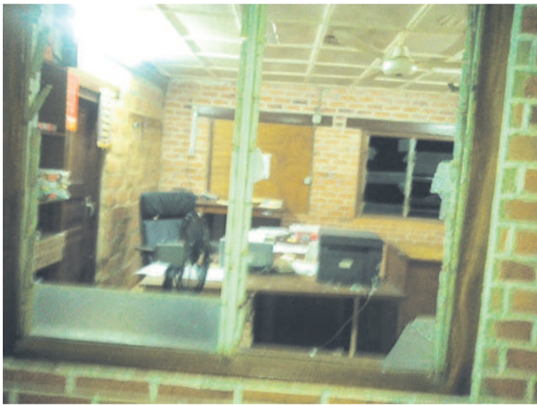
Les bureaux des éco-gardes vandalisés
