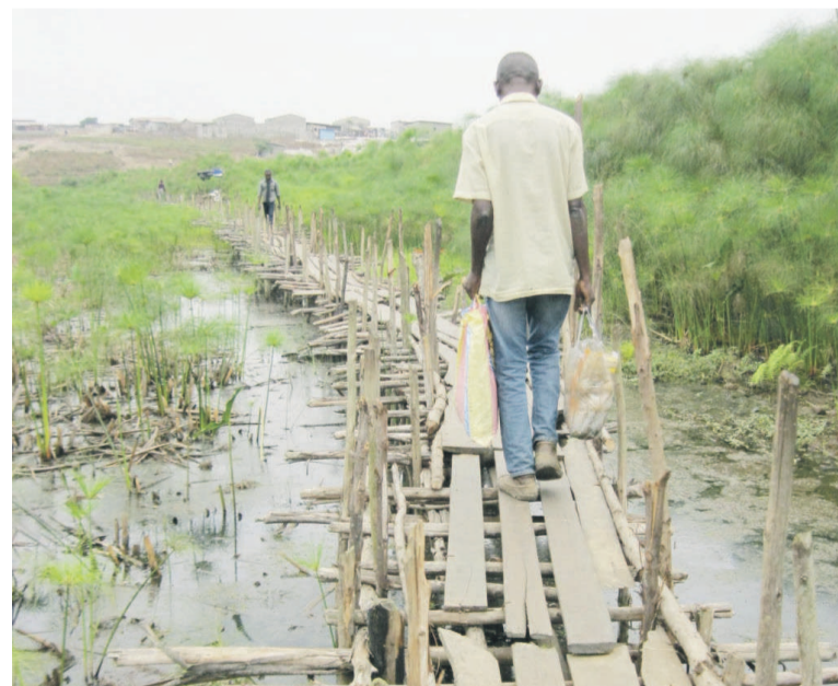
La passerelle « la Gazelle » crédit photo Adiac
