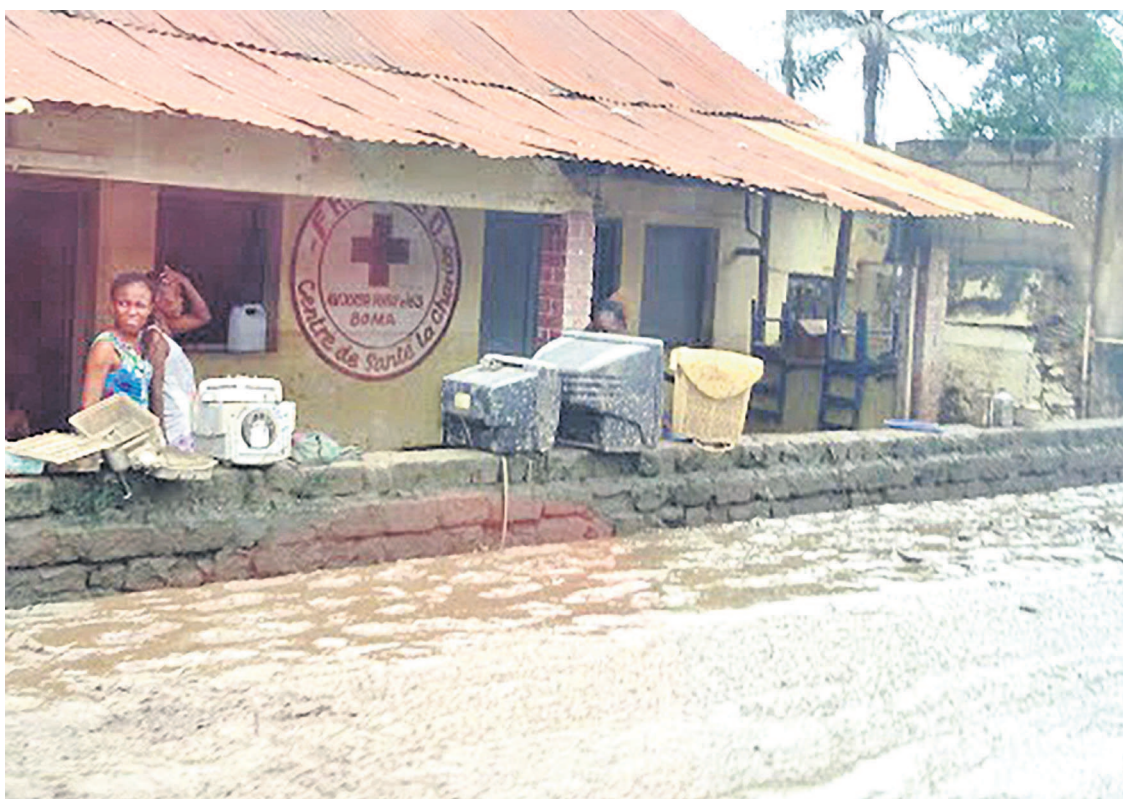
Une maison inondée à Boma
