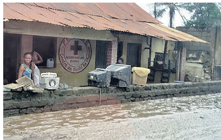
Une maison inondée à Boma
