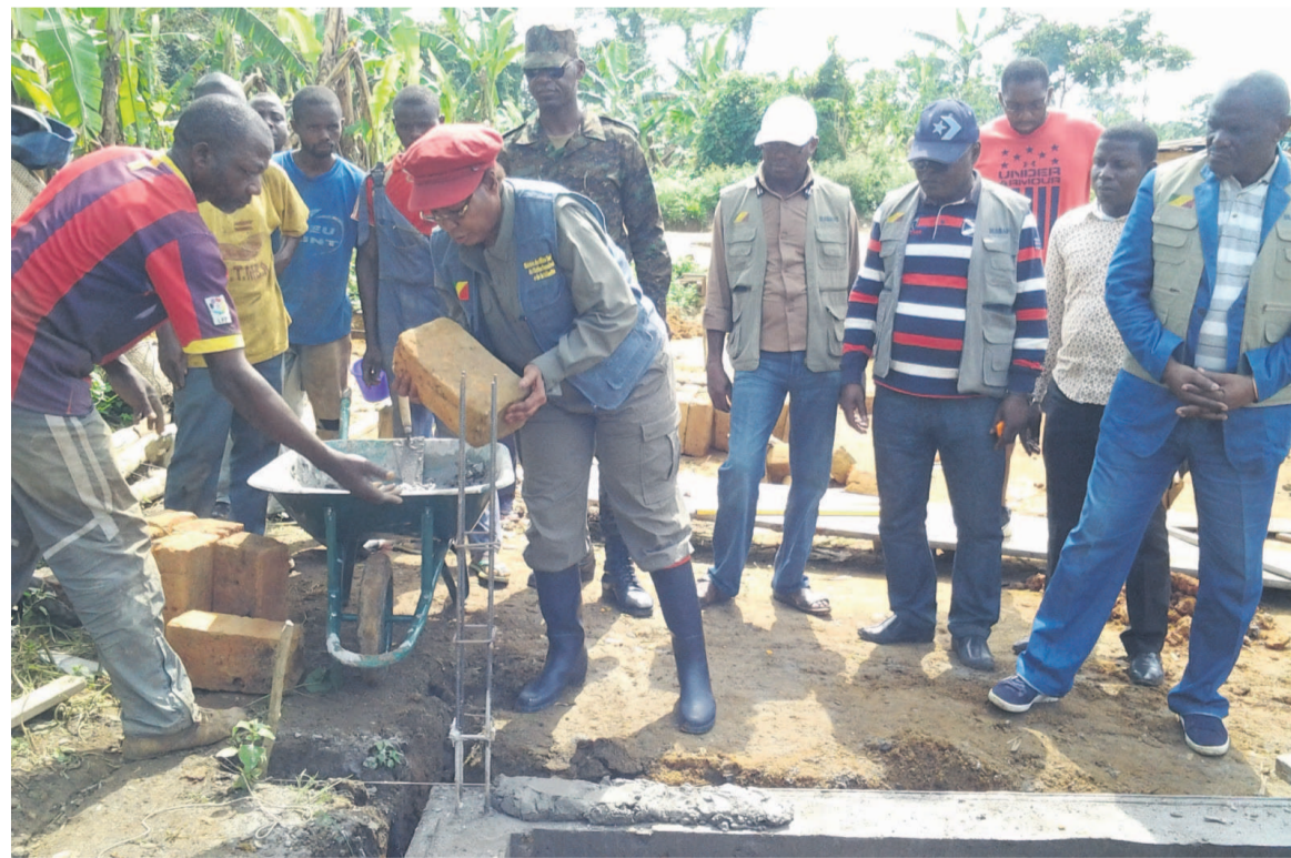
Antoinette Dinga Dzondo lançant les travaux à Lilendé ; crédit photo Cabinet
