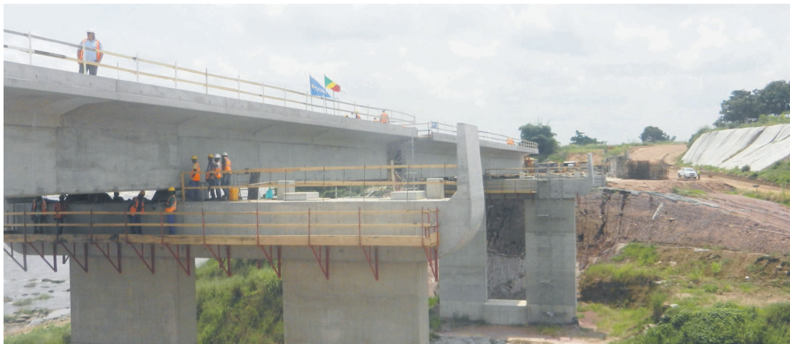
Un ouvrage d'art sur le chantier de la corniche sud de Brazzaville
