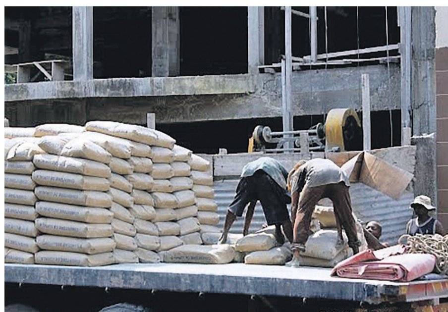
Déchargement d'une cargaison de sacs de ciment
