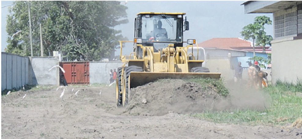
Une vue des travaux de réhabilitation «adiac» -Vue de la niveleuse, après le passage de la pelle mécanique «adiac»
