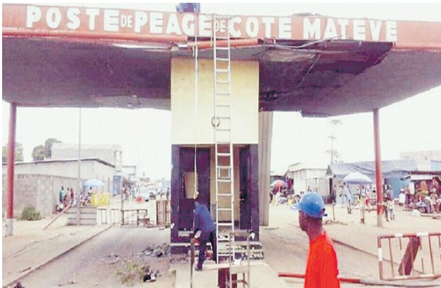
Démantèlement du poste de péage de Côte Matève crédit photo «DR»
