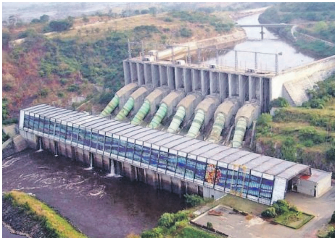
Le barrage Inga III toujours en chantier
