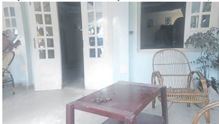
La porte centrale de la maison saccagée (photo adiac)
