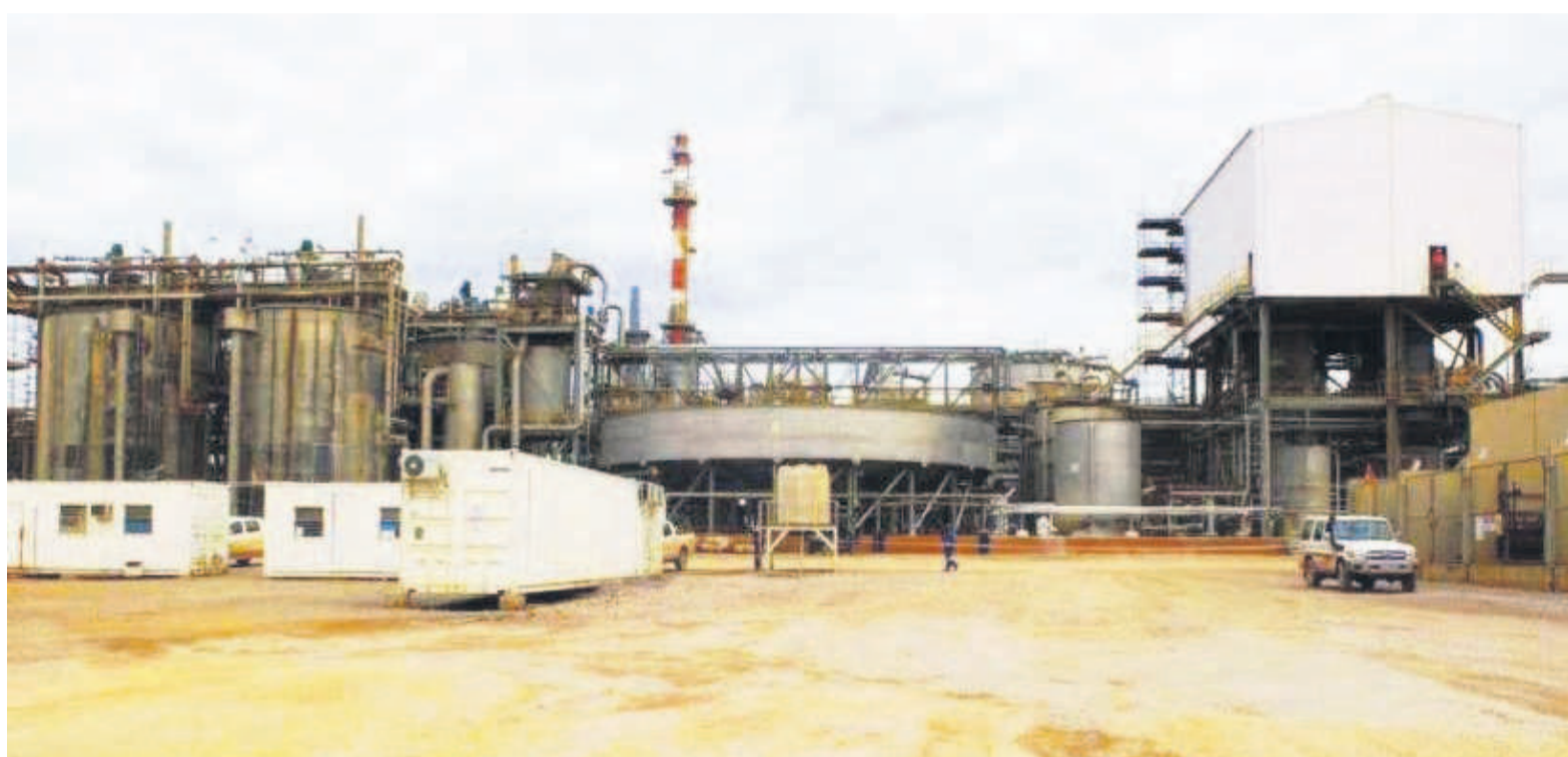
Les installations de Teke Fungurume
