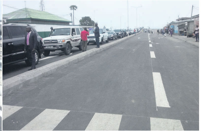
Le passage sud de l'échangeur (Adiac)
