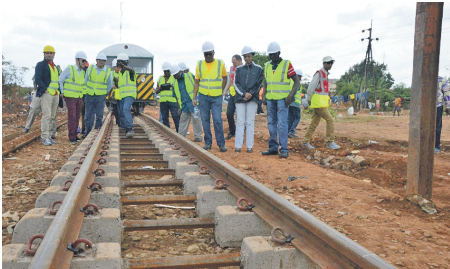
La visite des chantiers par l'équipe de la Banque mondiale
