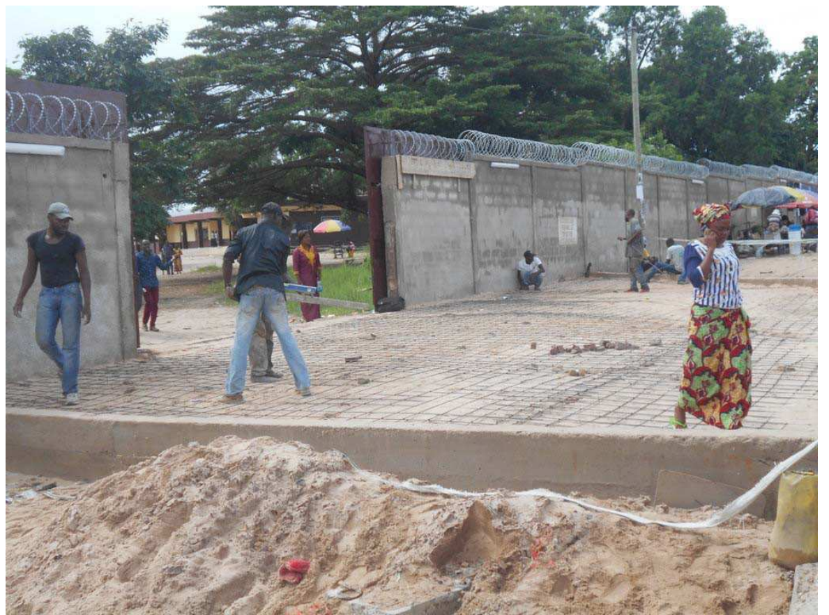
Les travaux à Thomas-Sankara/Adiac
