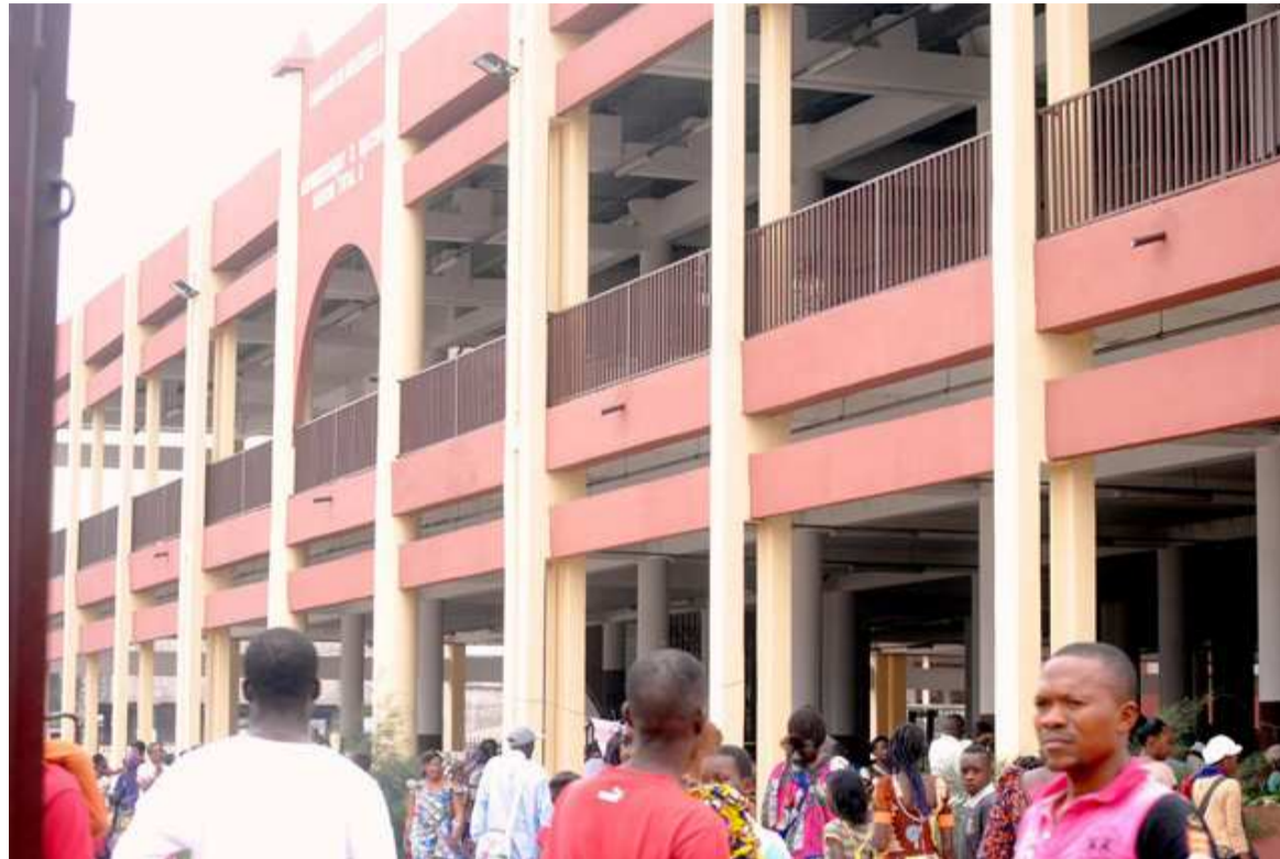
Le 1er module du marché Total de Bacongo vide à l'étage
