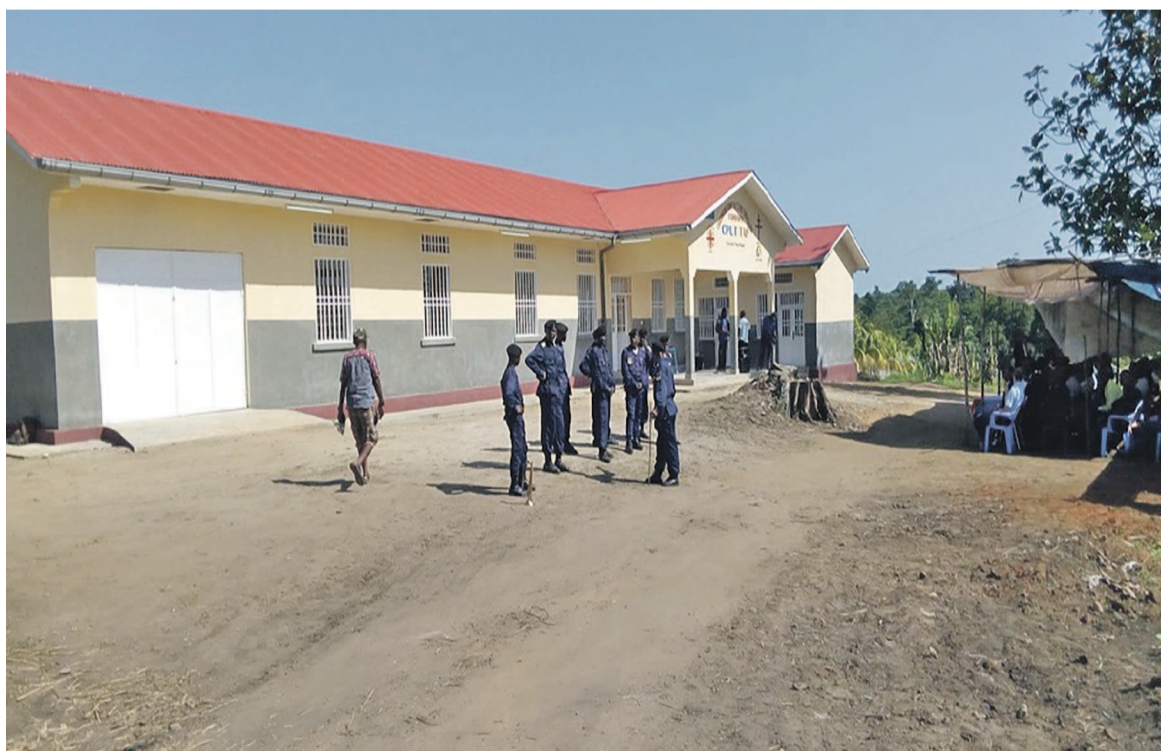
La vue externe du bâtiment de la coordination lèpre et tuberculose à Tshuapa
