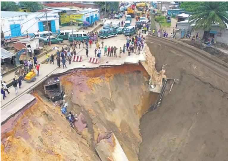
Une érosion /Photo Adiac
